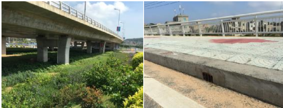
龙南大桥桥面雨水收集
