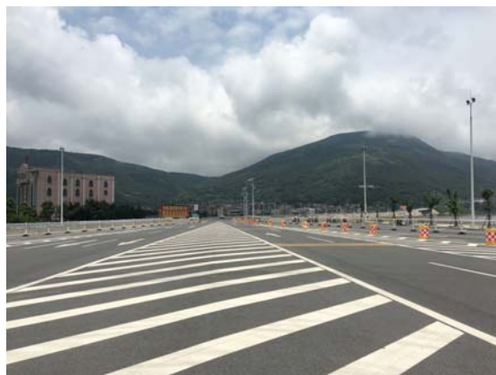
项目终点方向现状（2）
